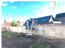
Pendant les travaux
