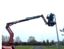
Dans le parking, les anciennes têtes d'éclairage équipées de lampes à vapeur de sodium ont été remplacées par des luminaires LED de dernière génération.
