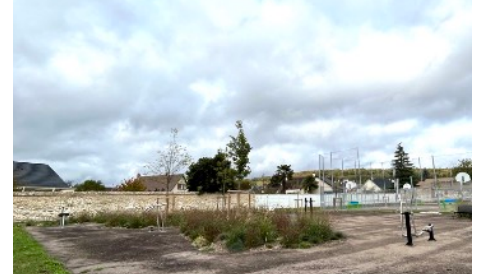
Aménagement d'un espace multisport avec notamment la pose d'appareils de fitness
